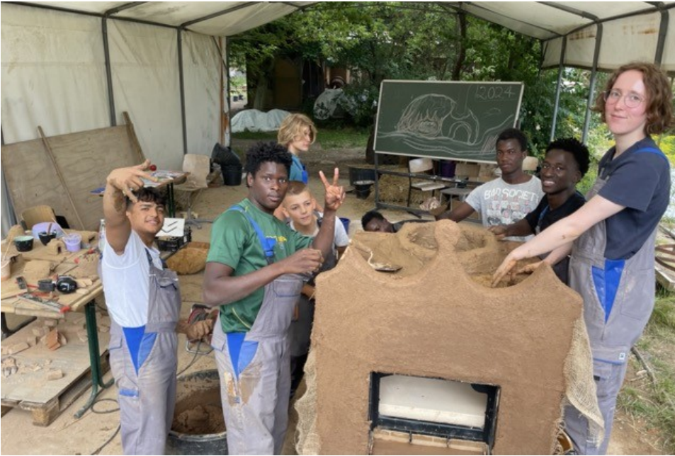
Bild 3: Nachdem der Lehmbackofen innerhalb von drei Tagen aufgebaut wurde, lassen die Teilnehmenden des Wangeliner Workcamps „Erde, Feuer & Brot“ ihrer Kreativität bei der äußeren Gestaltung freien Lauf. Wenn ausreichend getrocknet, wird noch Farbe angebracht. (Foto: Sandra Schattschneider)
