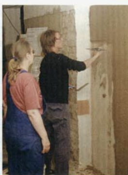
(von oben) Das Seminarhaus des FAL wurde aus Strohballen gebaut und innen wie außen mit Lehm verputzt
