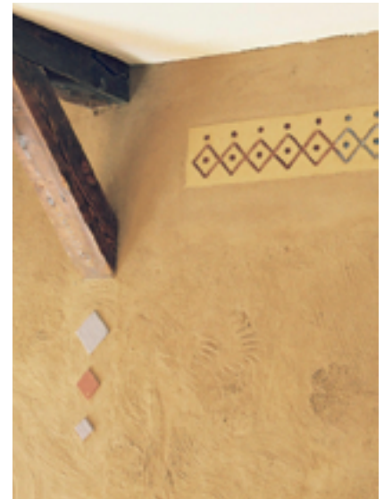
Lehmputze im Treppenhaus des Gutshauses Klein-Dammerow, heute als Jugend-Gästehaus genutzt. Ehemalige LPG-Arbeiterinnen gestalteten dort Lehmoberflächen unter Anleitung von Irmela Fromme.
